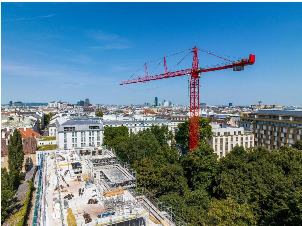
Mit 7,0 Tonnen Spitzentragefähigkeit bei 80 Metern Ausleger ist der WOLFF 8060.25 Cross der derzeit stärkste Baukran Österreichs.
