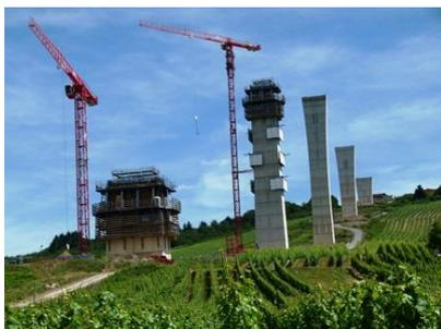
Die beiden WÖLFFE kommen für acht Brückenpfeiler zum Einsatz, von denen die höchsten 160 Meter hoch werden. Mehrere Umsetzungen mit Klettervorgängen und Abspannungen machen das Projekt im windanfälligen Moseltal zur besonderen Herausforderung.
